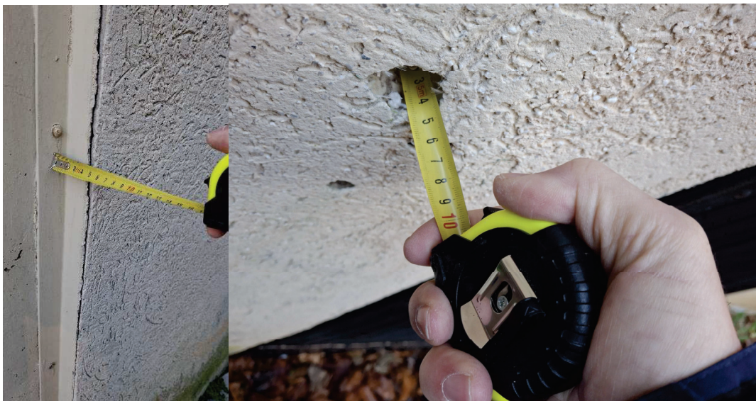
Slika 5: Obstoječe 5 cm toplotne izolacije (stiropor) na čelnih fasadah
