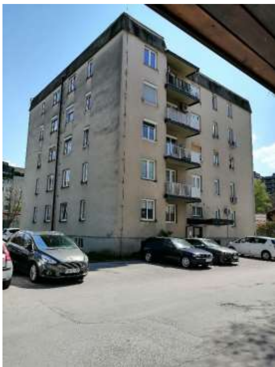
slika 3, – severna in zahodna fasada
