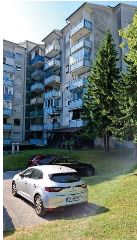
Slika 4: Del zahodne in severna fasada
