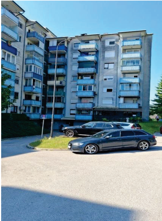
Slika 7: Severna fasada objekta
