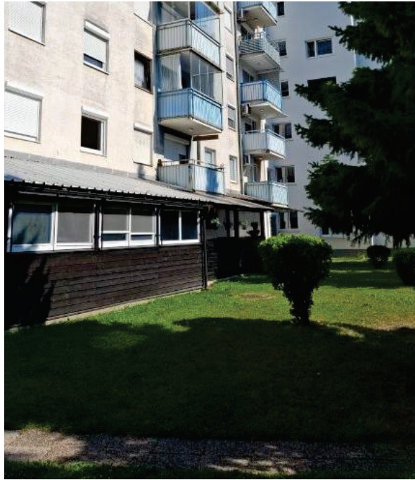
Slika 14: Nadstreški ob objektu
