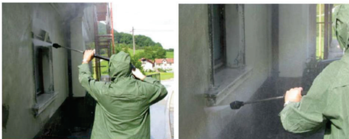
Slika 11: Čiščenje fasade pred izvedbo del
