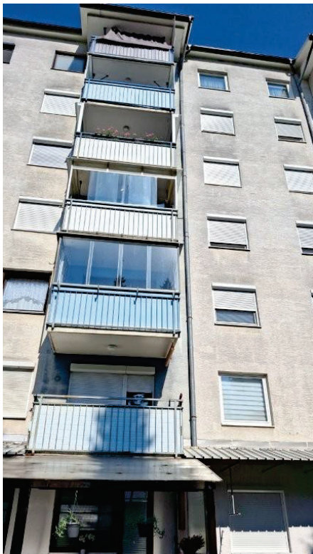
Slika 13: Balkoni na objektu Šalek 93
