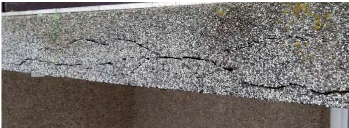
Slika 12: Sanacija poškodovanih betonov
