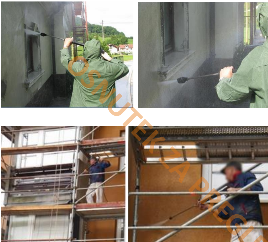
Slika 5 – prikaz visokotlačnega pranja z vodo, na fasadnih površinah
