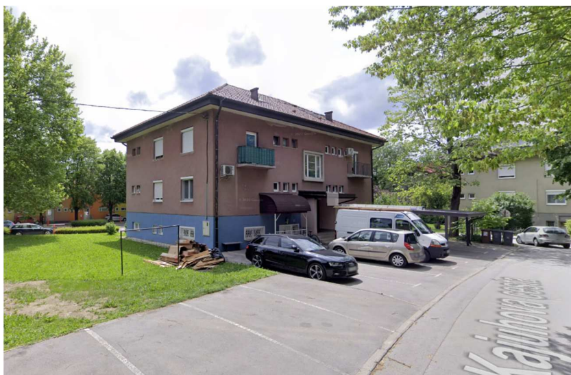
slika 1 – vzhodna in severna fasada
