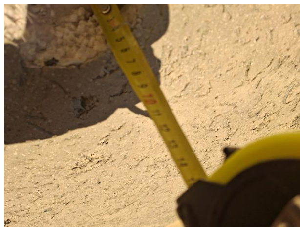
Slika 5: Obstoječa 5 cm toplotne izolacije (stiropor) na čelnih fasadah
