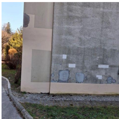
Slika 5: Obstoječa 5 cm toplotne izolacije (stiropor) na čelnih fasadah
