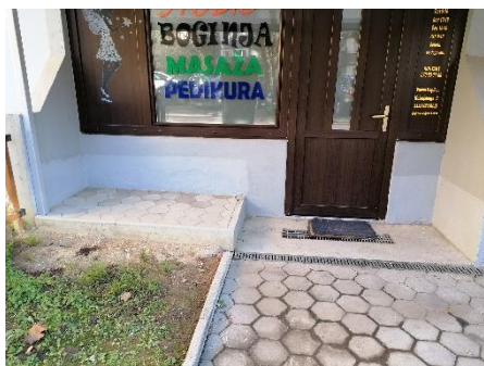
DETAJL – podzidek ob betonskem in asfaltnem tlaku
