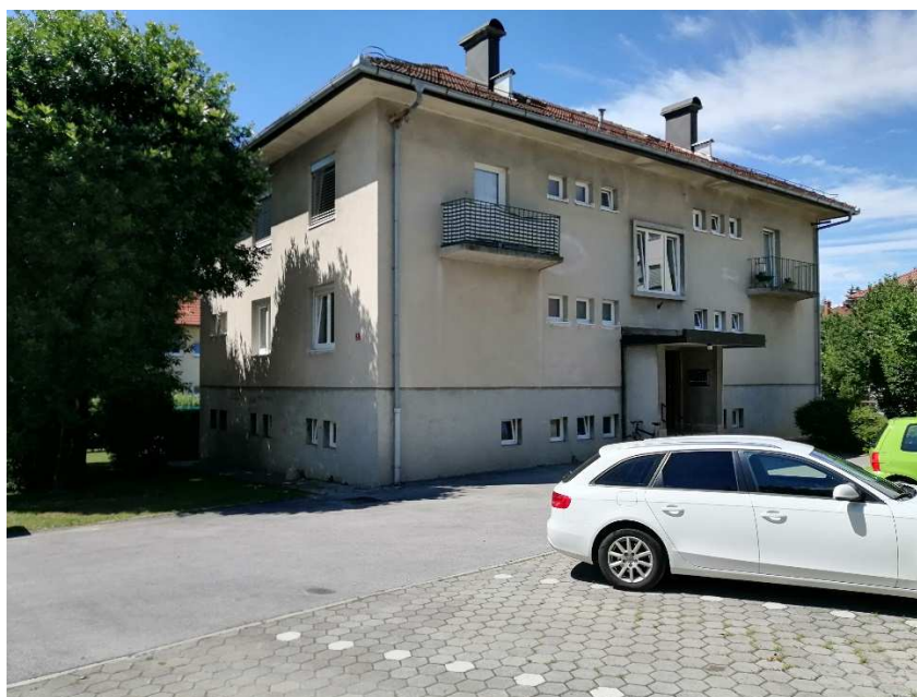
slika 1 – vzhodna in severna fasada
