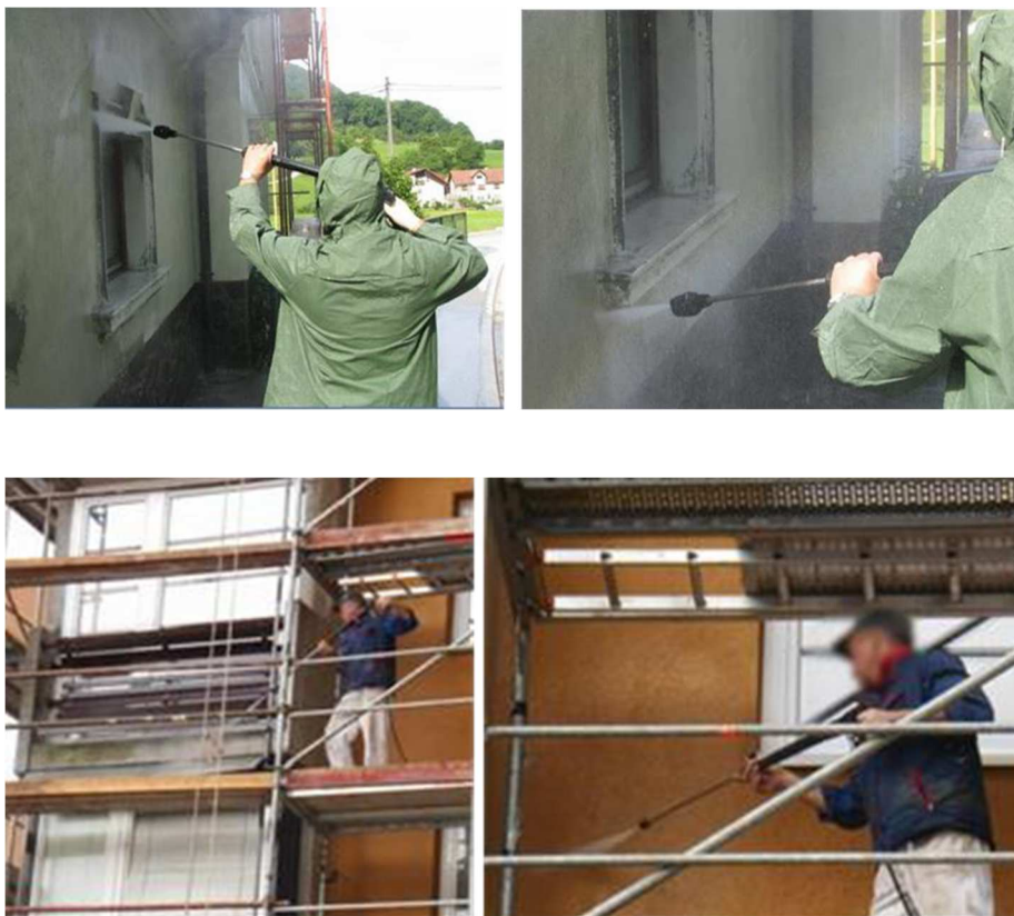
slike 5 – prikaz visokotlačnega pranja z vodo, na fasadnih površinah
