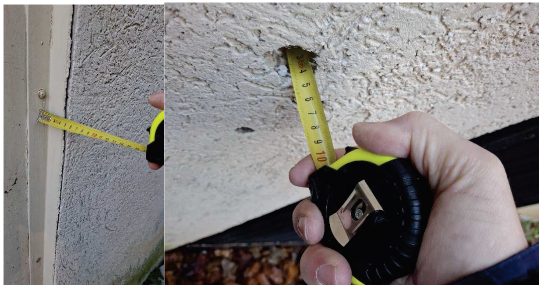
Slika 5: Obstojee 5 cm toplotne izolacije (stiropor) na čelnih fasadah
