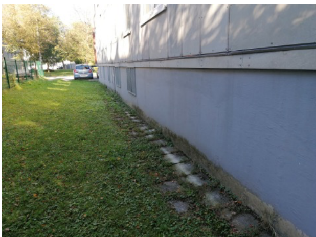
Slika 26: Betonski cokl
