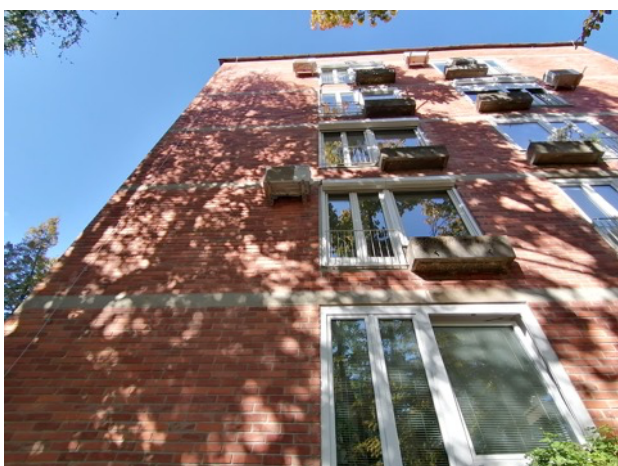
Slika 28: Opečna fasada z okni
