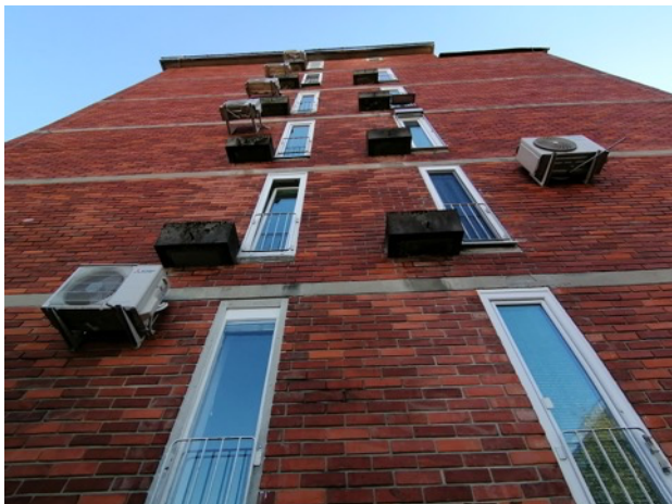
Slika 18: Opečna fasada
