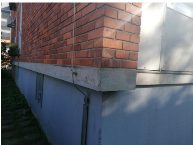
Slika 20: Betonski venec
