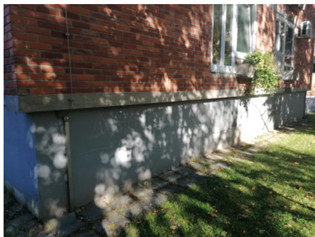
Slika 27: Betonski cokl
