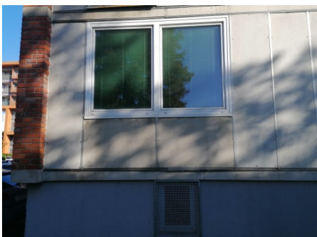
Slika 22: Okno na fasadi
